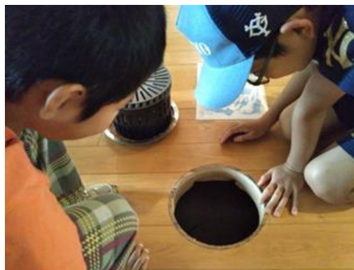
地下水を使った冷房ファン
