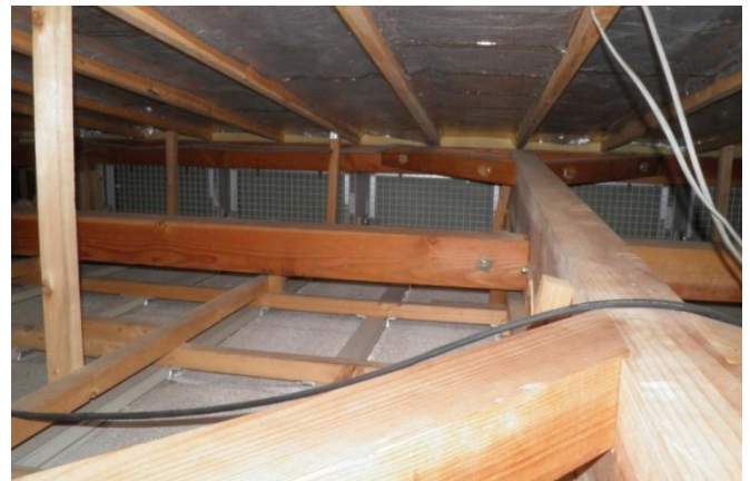
天井裏下のガラス繊維を濡らし、窓を開けて熱を逃がす
