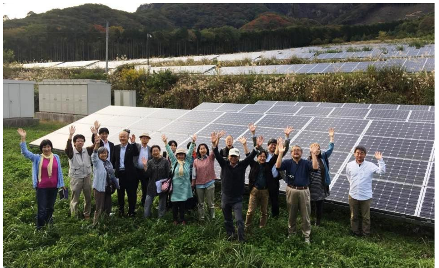
中之条町に電力を供給する沢渡第1発電所
