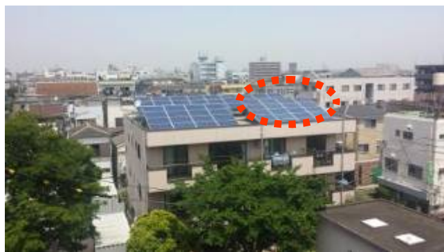
えど・そら2号機(ほっと館)の最近の様子。点線で囲まれた部分が、パネルの更新工事を行った市民立第二発電所です。発電出力は3.0kWから4.9kWに増強されました。
